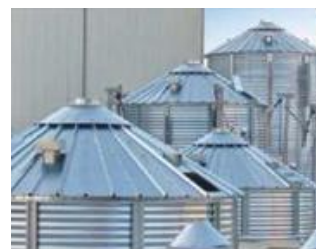
DACH SIŁOSU 30° ROOF SILO 30°
